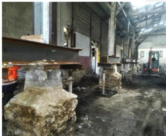
Reprise en sous œuvre des poteaux de la charpente d'un atelier de maintenance SNCF dans le centre Villeneuve Triage.
